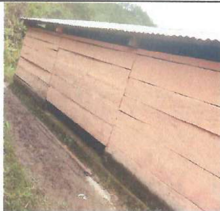
Foto 1: Mejoramiento de modulo de aula tipo portico
