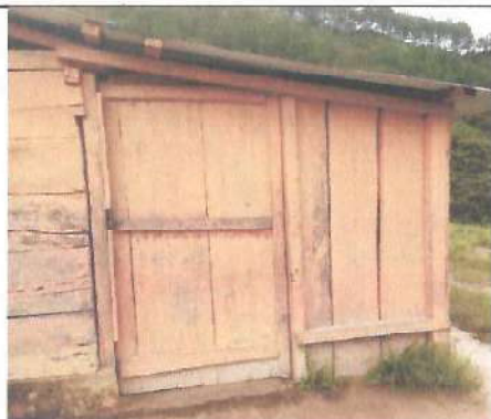
Foto 3: Mejoramiento de modulo de aula tipo portico
