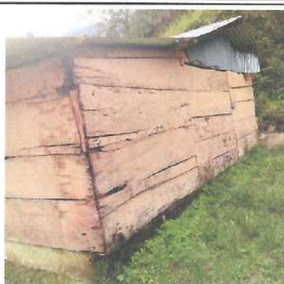
Foto 2: Mejoramiento de estructura de techo con lamina troquelada calibre 26
