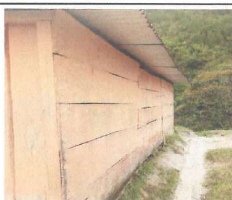
Foto 4: Mejoramiento de aula tipo portico
